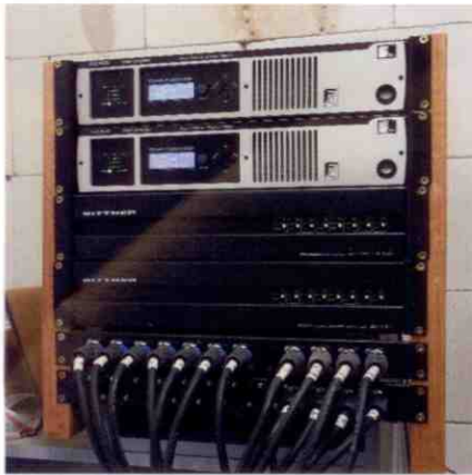
Zwei DSP-bestückte D-2.1500-Amps von Fohhn versorgen acht unter der Tribüne platzierte Subwoofer, während sämtliche anderen Lautsprecher über zwei achtkanalige „8X 400“-Endstufen von Bittner Audio angetrieben werden.
