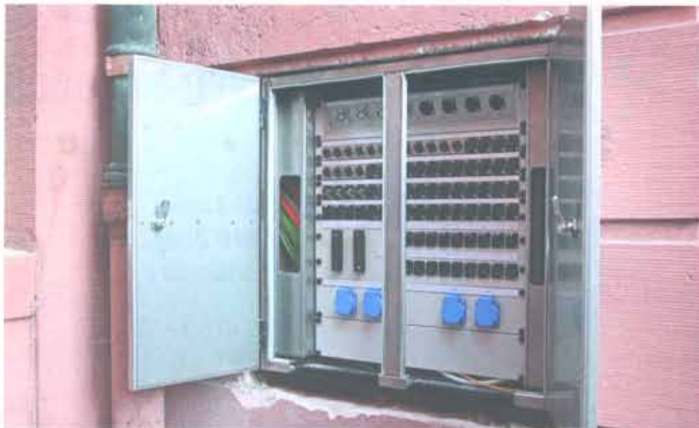
An der Außenseite des Doms befindet sich ein Anschlussfeld, an das sich Ü-Wagen komfortabel ankoppeln können.
