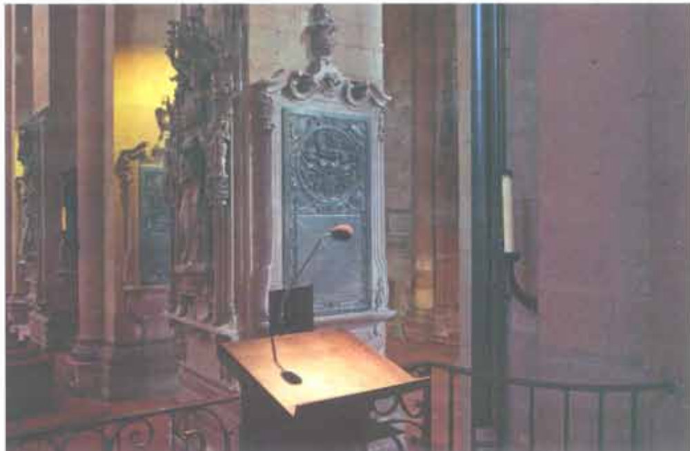
Das Schwanenhalsmikrofon am Ambo ist in einer speziellen Gummihalterung gelagert. Rechts im Bild zu sehen ist ein Abschnitt eines DSP-Linienstrahlers.
